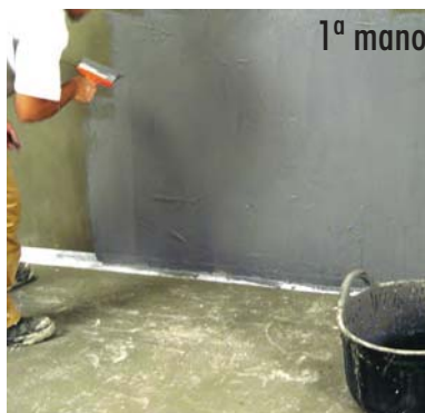
Aplicación de la 1ª mano de HIDROELASTIC .
