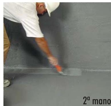
Aplicación de la 2ª mano de HIDROELASTIC .
